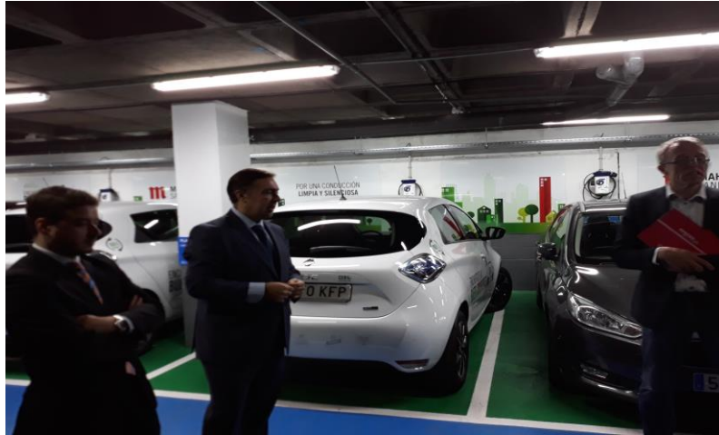
Estacionamento da estação com vagas especial e equipamento para recarga de carros elétricos.
